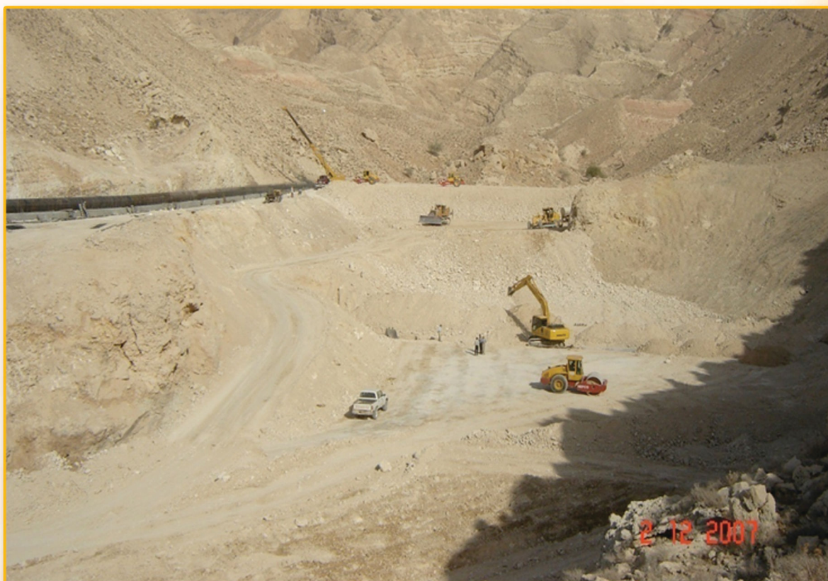
پروژه سد ۱۴ D تمبک در منطقه انرژی پارس ۲ (استان بوشهر - کنگان)
