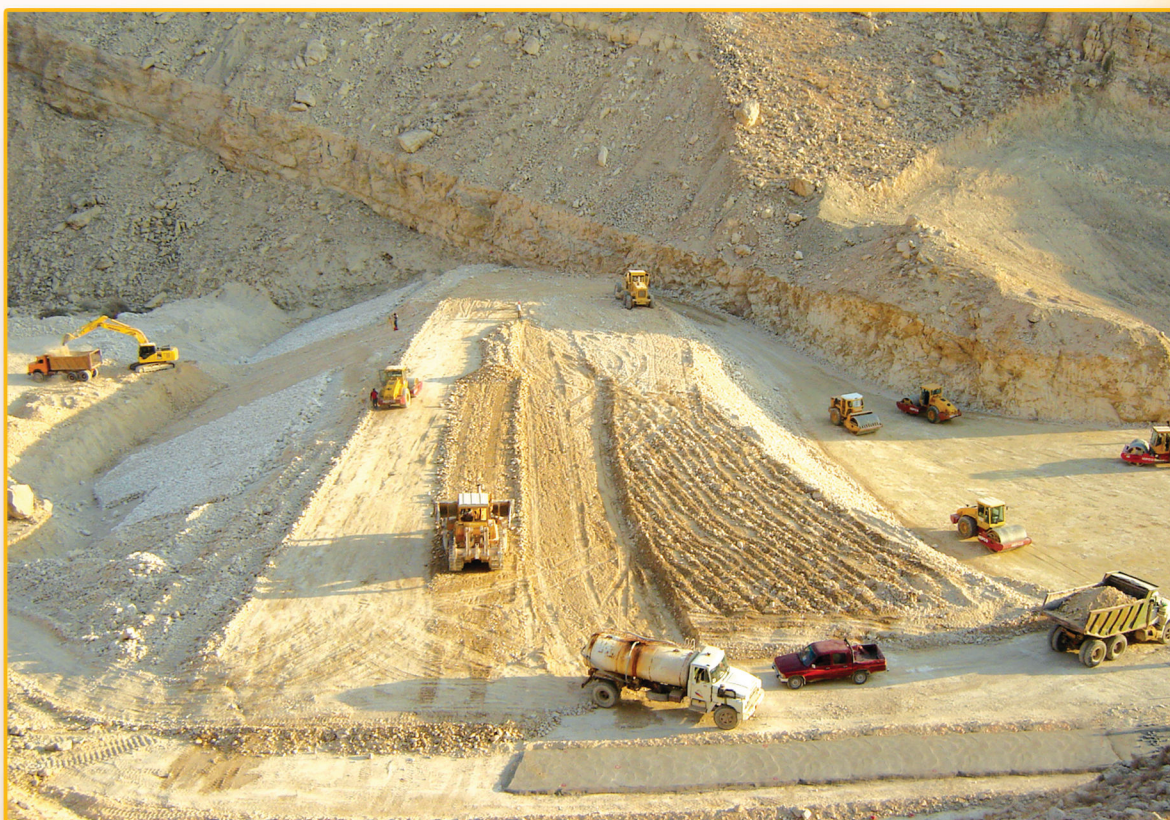
پروژه سد ۱۴ د تمبک در منطقه انرژی پارس ۲ (استان بوشهر - کنگان)
