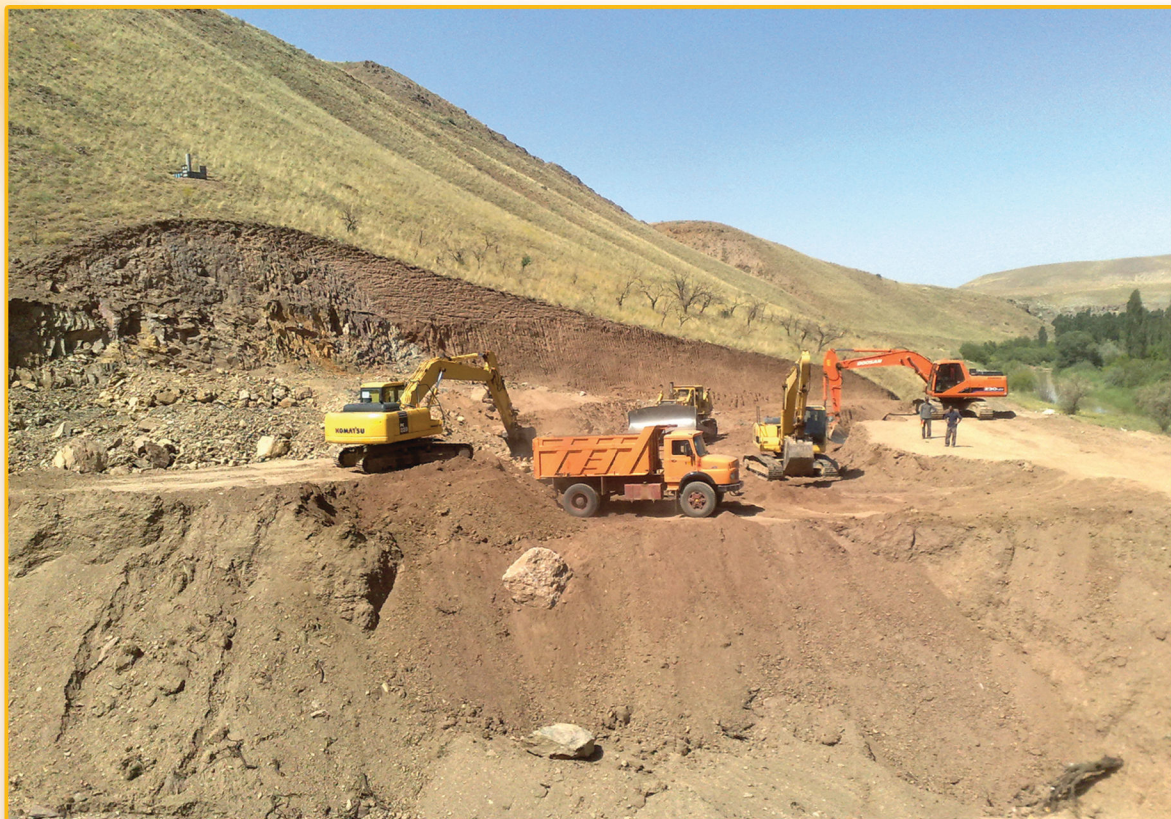
پروژه سد بلوین
