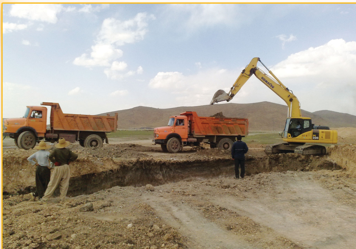
پروژه راه آهن مراغه - ارومیه
